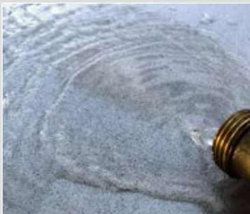
1. Wet the slab.
